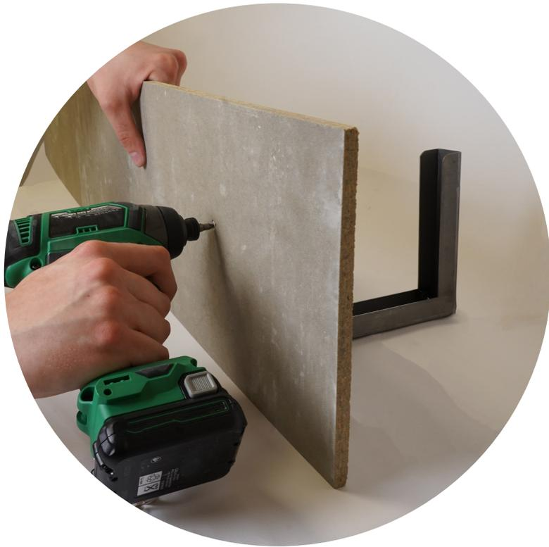
**Step 1: Positionieren:** Lege das Verbindungselement zwischen die beiden Schalungsbretter an der Verbindungsstelle.
